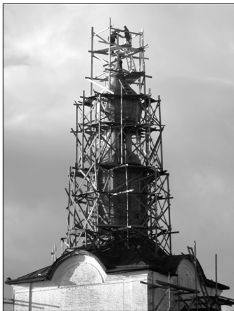
Над въездными, парадными воротами монастыря легко парит купол храма во имя прп. Сергия Радонежского. В последние годы это изящное сооружение охвачено лесами — идут кровельные работы.
