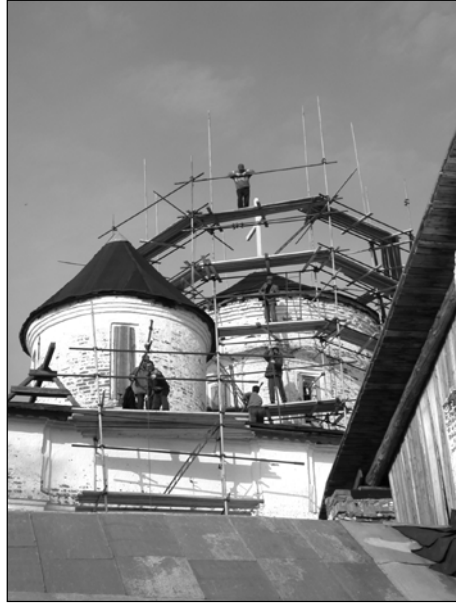
После разорения и закрытия монастыря собор был обезглавлен. Ныне первым будет возведен его главный купол.
