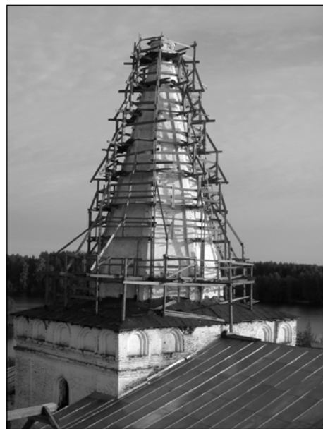
Уже не один год идут службы в Благовещенской церкви. Недавно был проведен косметический ремонт не только внутри нее, но и в трапезной. Но шатер уже несколько лет в лесах...
